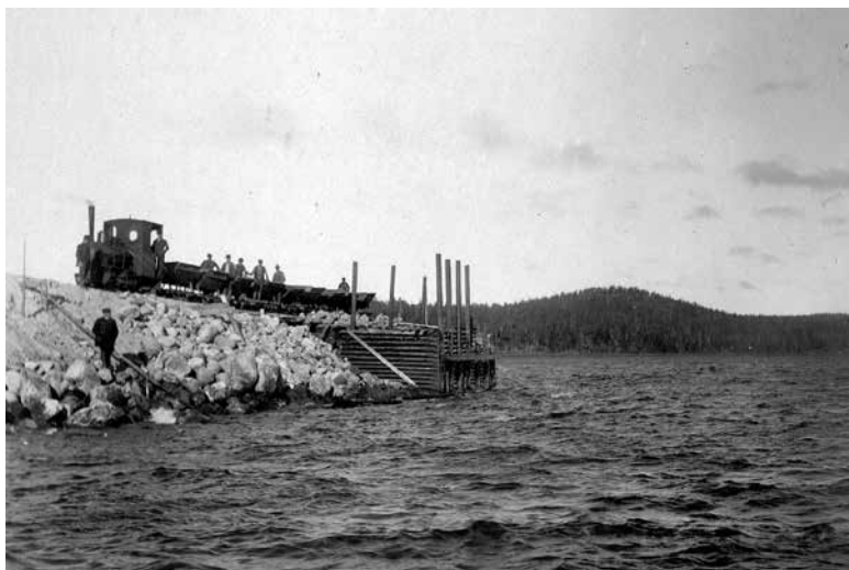
Anläggning av omlastningskajen vid Råktjärvändan.
