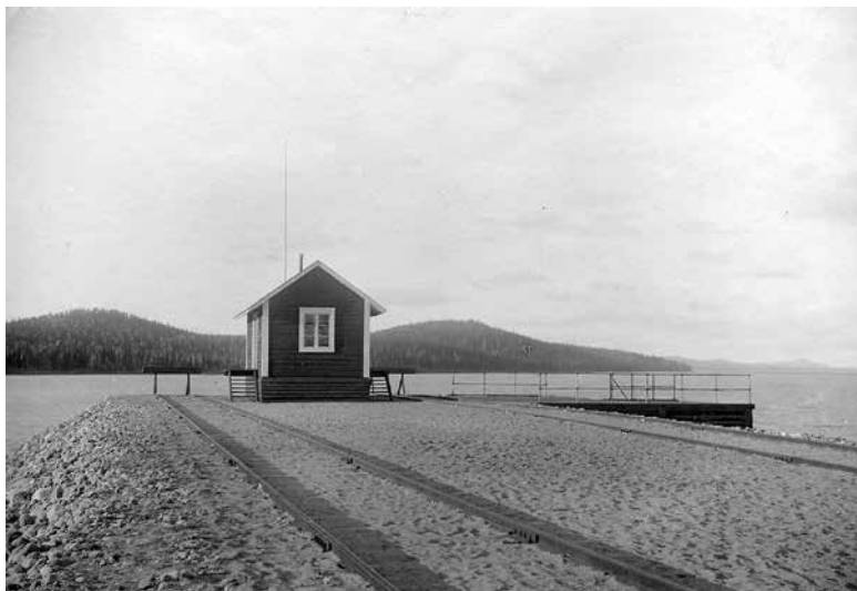
Omlastningskajen i Råktjärvändan efter färdigställandet med spår och expeditionsbyggnad med väntrum.
