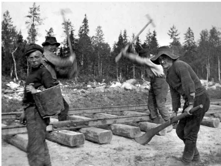
Rälsläggning vid banbygget mellan Morjärv och Karungi.
